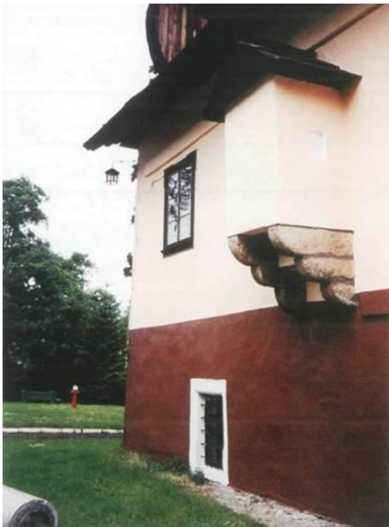
Fot. 33. W ścianie południowej na piętrze oryginalna latryna na kamiennych konsolach
